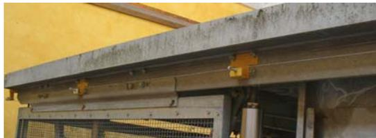
Una canalina perimetrale è stata montata su tutto il bordo del cortile e, mediante un gocciolatoio posizionato sul cappello degli impianti, garantisce la **completa raccolta dell'acqua** piovana. Sono comunque previsti dei pozzetti sul fondo della fossa per la raccolta di eventuale acqua che dovesse entrare nei vani durante la movimentazione.
